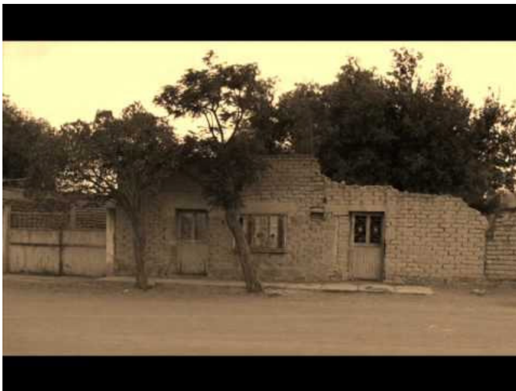
Fotografía 1. Parte del edificio de la escuela. Chinacates, Durango, 1933. Archivo Familia del Palacio.
